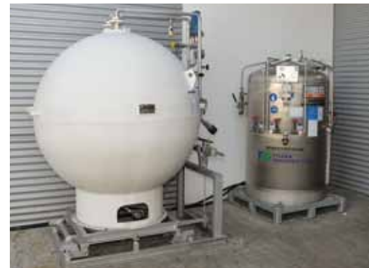
Ein 600-l-CryoEase®-Behälter mit Stickstoff sowie ein 1,1 Tonnen CO 2 -Tank versorgen die Pizza-Produktion
