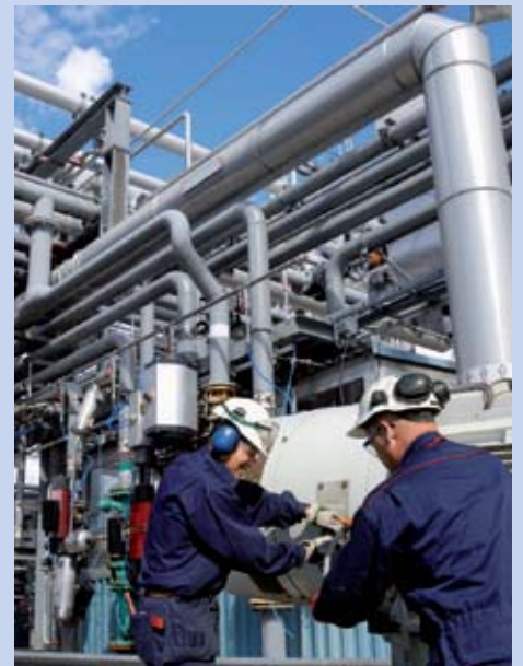
Schutzgas im Rohrleitungsbau
