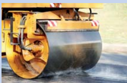
Aufheizen von Asphalt
