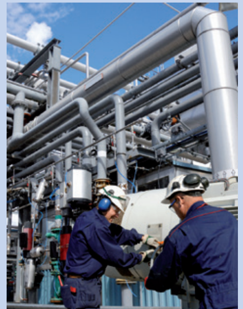
Dichtheitsprüfungen von Rohrleitungen
